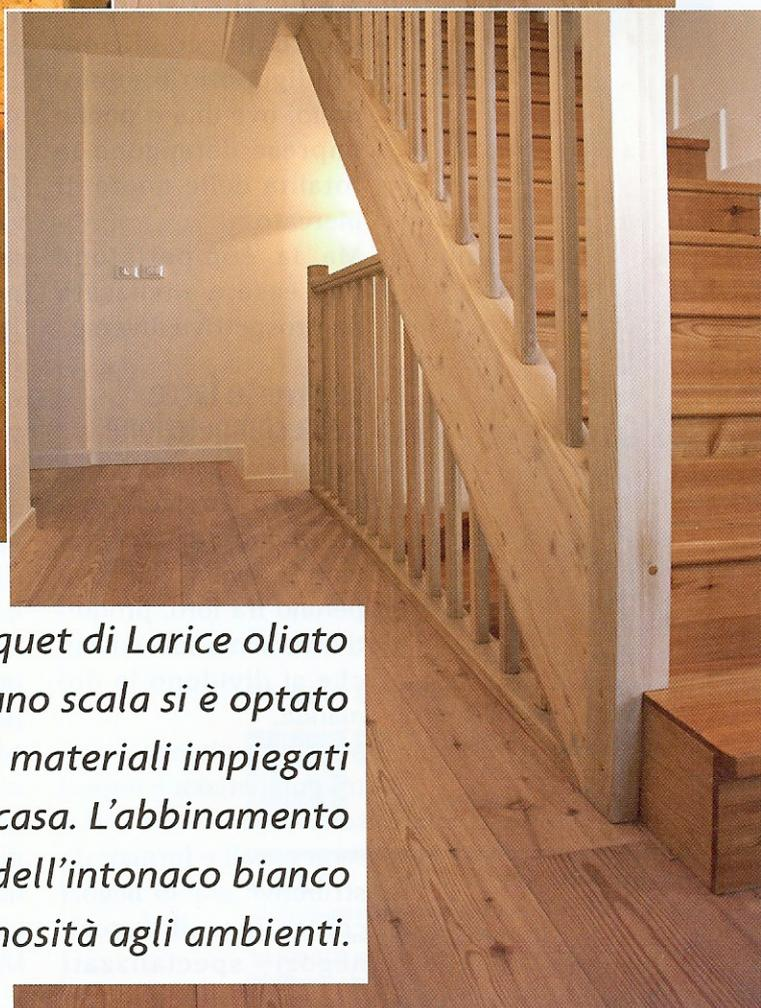
*In tutta la casa è stato posato il parquet di Larice oliato e spazzolato e anche per il vano scala si è optato per l'uniformità dei materiali impiegati per la ristrutturazione della casa. L'abbinamento del legno chiaro e dell'intonaco bianco si ripete dando luminosità agli ambienti.*
